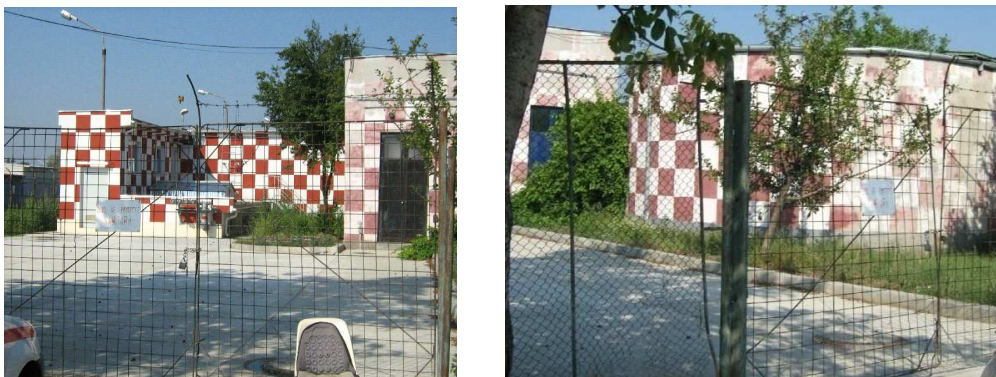
Fig. 22 Principala stație de distribuție a apei și rezervorul de apă
