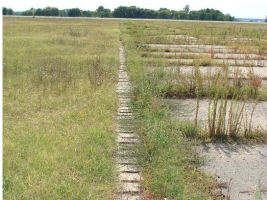
Fig. 27 Zona de depozitare a zăpezii (Calea de rulare Papa)
